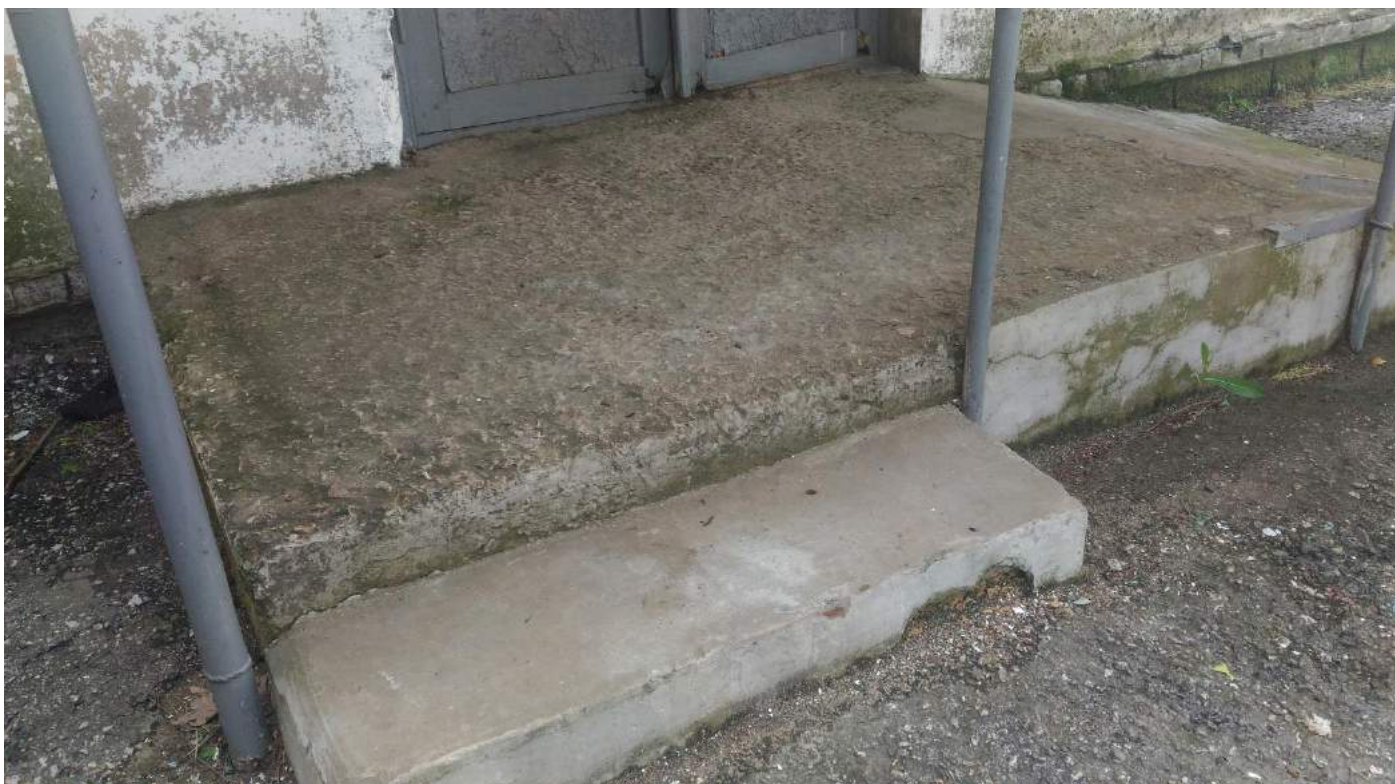
Входная площадка (перед дверью)
